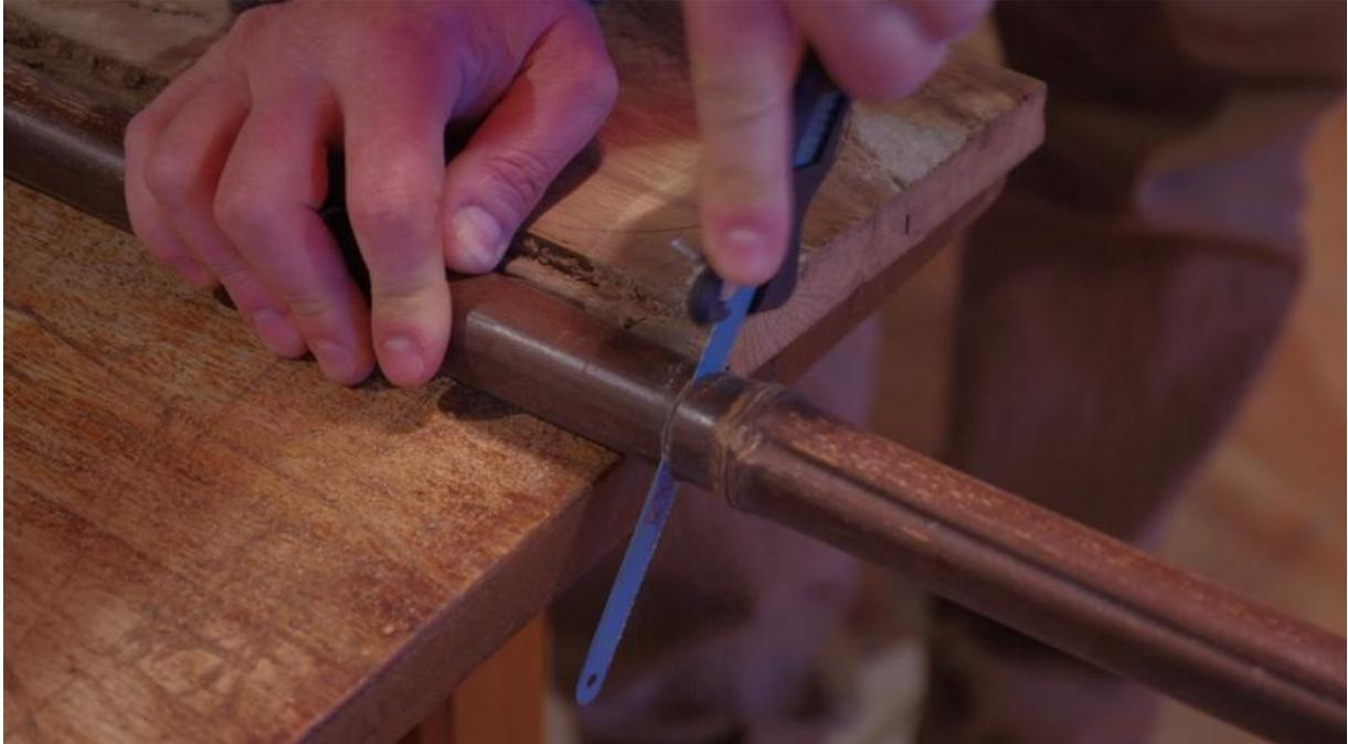
A l'aide de la scie à métaux, coupez la tige à 1 ou 2 cm au-dessus d'un nœud annulaire. On utilise la scie à métaux et ses petites dents pour éviter d'arracher la partie supérieure du chaume.
