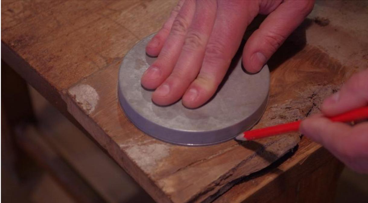
A l'aide d'un couvercle ou d'un compas, tracez un cercle dont le diamètre correspond à 4 fois le diamètre d'une tige. Dans cet exemple les tiges font 3 cm de diamètre, le cercle fait donc 12 cm. Repérez le centre du cercle.
